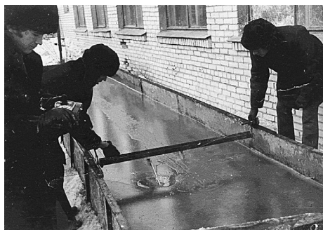
Рис. 3. Приготовление модельного льда в ледовом бассейне.
