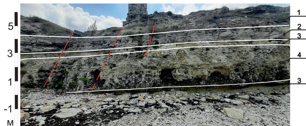
Рис. 1. Стратифицированный геологический разрез абразионного клифа. 1 – суглинки; 2 – известняк скальный; 3 – глина набухающая; 4 – известняк полускальный; красным цветом показаны линии разломов; белыми линиями – границы слоев.
