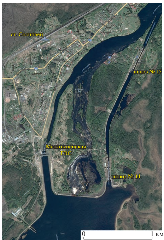
Рис. 3. Фрагмент зоны Беломорско-Балтийского канала на отрезке шлюзов 14 и 15 (снимок Google). Естественное русло реки обезвожено; основной сток направлен на турбины Маткожненской ГЭС (к югу от пос. Сосновец).
