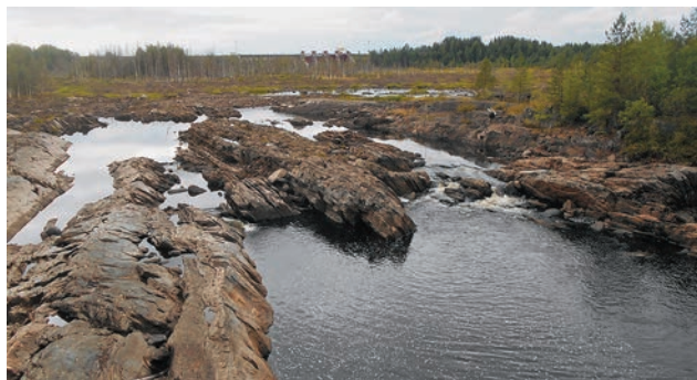
Рис. 4. Оголенное скальное ложе р. Выг на пороге Маткожня. Вдали — водосливная плотина Маткожненской ГЭС. Фото А. Лукашова.
